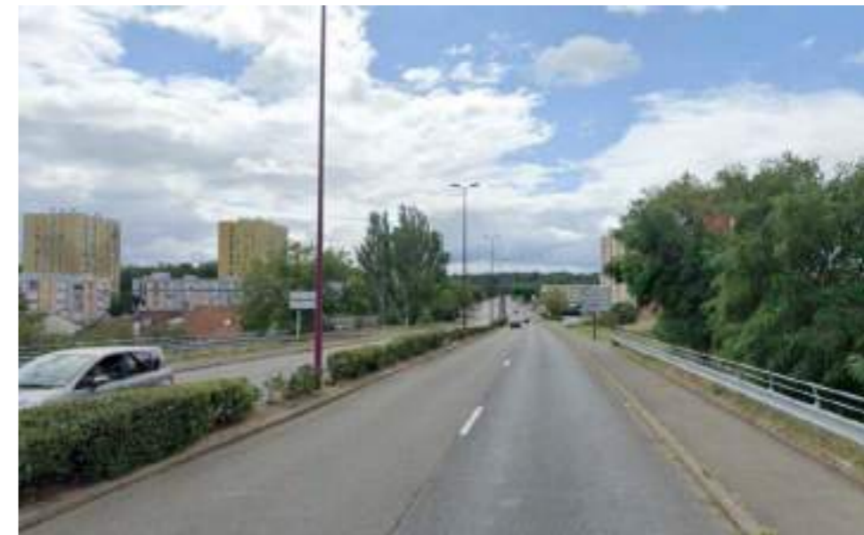
Figure 31 : Boulevard Cugnot existant - vers Sablons
